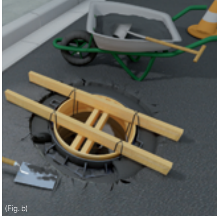
Instalación del marco, nivelado, encofrado (Fig. b)
